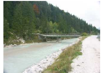
Abbildung 1: Brücke über die Isar
